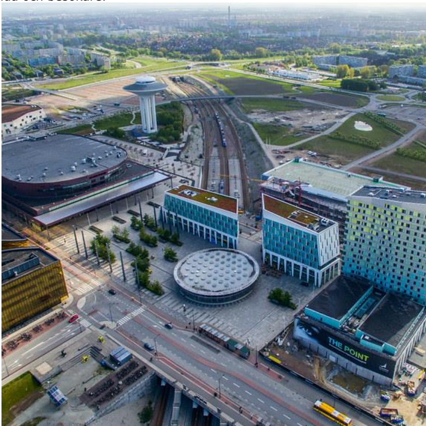
Figur 52. Hyllie Station i södra Malmö.
