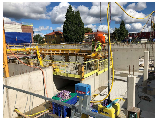
Gjutning av betongbalk runt rehabassäng i hus 04
